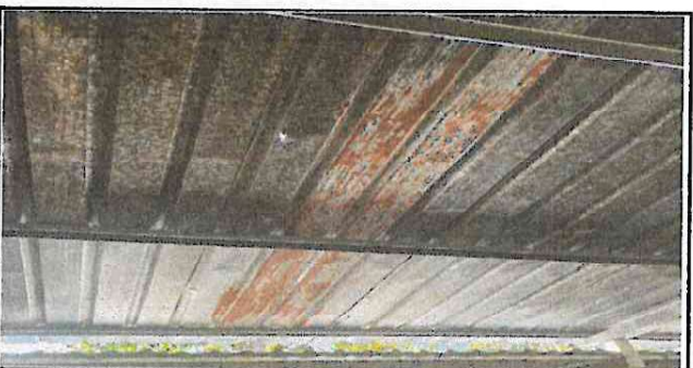
Foto 6: Sustitución de lámina por lámina troquelada
