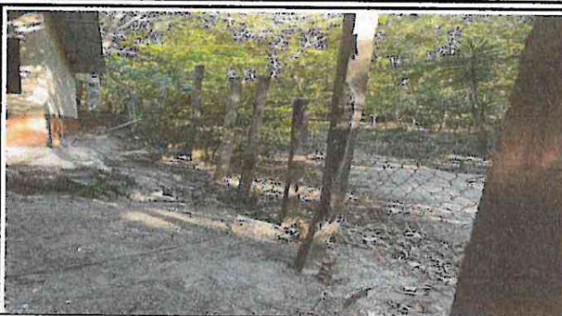
Foto 2: Reparación de muro perimetral
