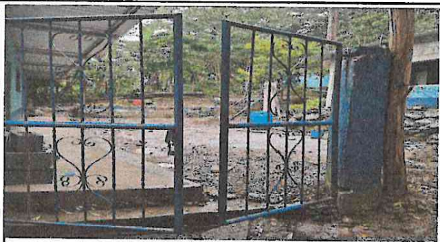
Foto 1: Mantenimiento de portón de metal (lijado, pintura y soldadura) en la entrada principal de la escuela.
