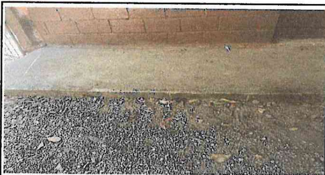
Foto 4: Reparación de plancha de concreto de patio
