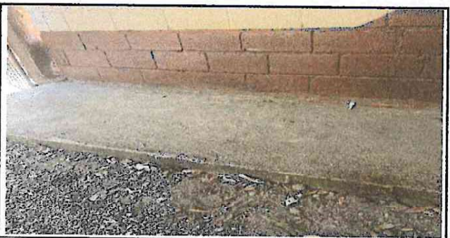
Foto 5: Reparación de plancha de concreto de patio
